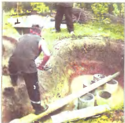
Самая глубокая часть водоема, в которой впоследствии будет установлен насос
