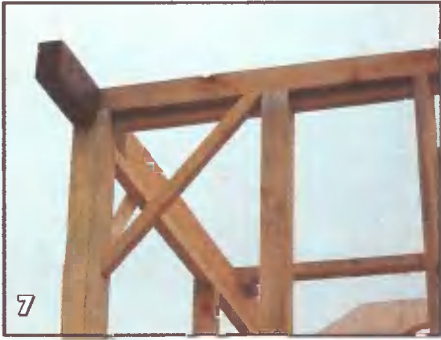
Точное изготовление деталей каркаса облегчило его сборку
