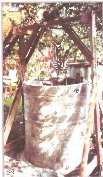
Рама с блоком для подъема ведер с грунтом установлена — можно опустить в грунт первую секцию колодца
