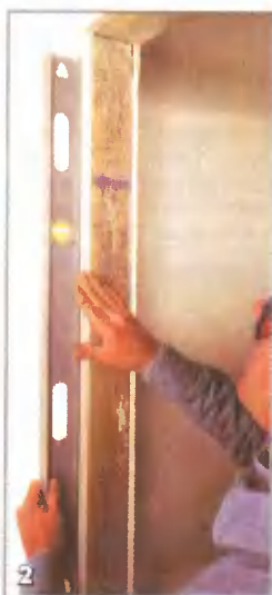
Проверка проема. Перед установкой двери убедитесь, что стойки вертикальны по обоим сторонам проема. Для этого можно использовать уровень длиной 1,8 м
