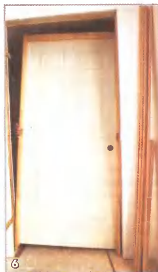
6 Прокладка на полу. Чтобы коробка заняла правильное положение при возможном опускании косяка со стороны замка, установите прокладку и снизу
