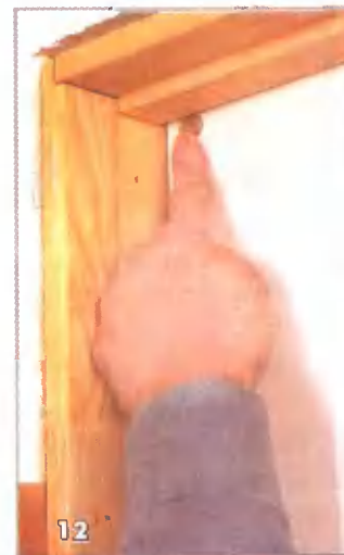
12 Для обеспечения равномерного зазора между закрытой дверью и бруском-ограничителем используйте монетку
