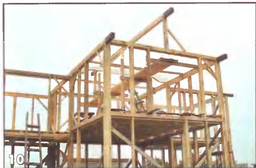
10 Завершается каркас коньковой балкой опирающейся стойками на верхнюю обвязку
