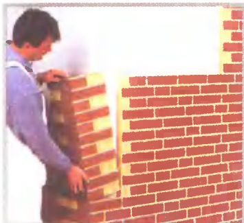
Укладка стеновых и угловых элементов
