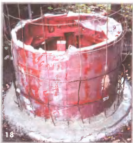
Внутренний цилиндр опалубки установлен на железобетонный «нож» по слою пескобетона. После монтажа арматуры можно устанавливать наружный цилиндр
