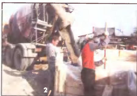
Укладка бетона в опалубку
