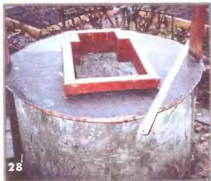
Под малой крышкой размещен насос «Малыш»
