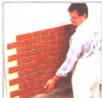
Укладка стеновых и угловых элементов
