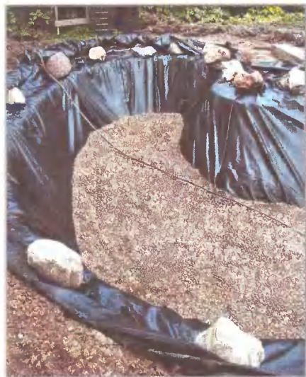
На дно водоема засыпают тяжелый грунт, а затем — слой гальки
