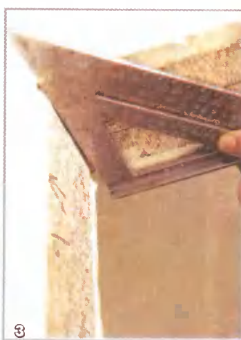
Если стойки установлены не под прямым углом к перемычке, косяк тоже будет установлен косо. Для проверки стоек на скручивание используйте треугольник
