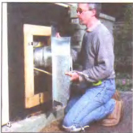
Вытяжной вентилятор собирают заранее. Для соединения элементов вентилятора используют винты и муфты. Зазор по периметру вентилятора герметизируют для защиты от неблагоприятных атмосферных воздействий
