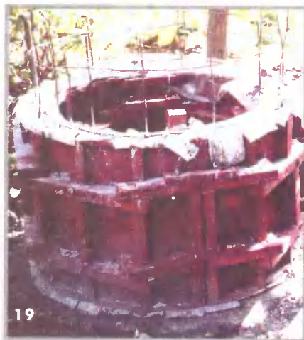
Для продления срока службы цилиндров их рабочую поверхность покрыли старой пленкой
