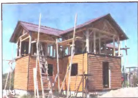
Крыша выкрашена и первый этаж обшит по гидроизоляции блокхаусом
