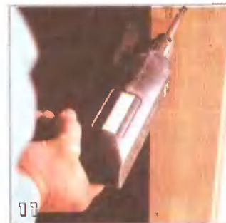
11 ... а затем вворачивают шурупы, крепящие коробку к стойке
