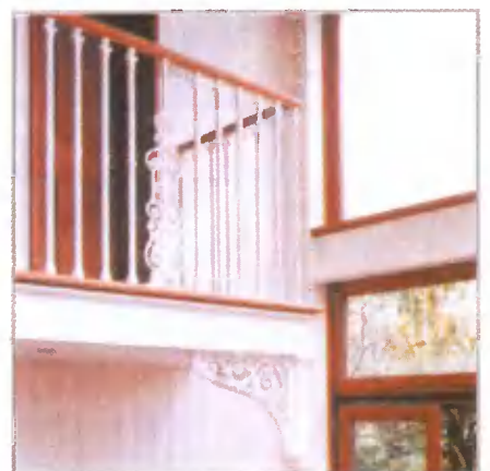
Бывший балкон сохранился, но теперь он находится внутри пристройки и возвышается над новой гостиной в качестве галереи
