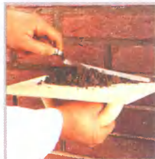
Герметизация стыков
