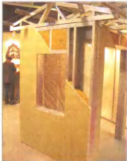
Технология сооружения облегченных зданий с применением термопрофилей для наружных стен. В основе постройки — каркас из стальных профилей, подготовленных заранее в заводских условиях. Проблема «мостиков холода» в стальном каркасе решается применением профилей с минимальным поперечным сечением, в которых в шахматном порядке прорезаются продольные сквозные канавки для увеличения пути прохождения теплового потока. Размеры заготовок для будущего здания рассчитывают на компьютере и нарезают на заводе. Окончательно каркас собирают с помощью обычного шуруповерта
