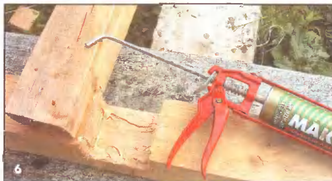
Нижнюю обвязку собрали на фундаменте на клею и саморезах
