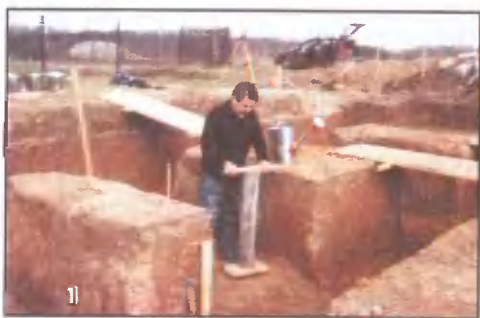
Изготовление противопучинной подушки
