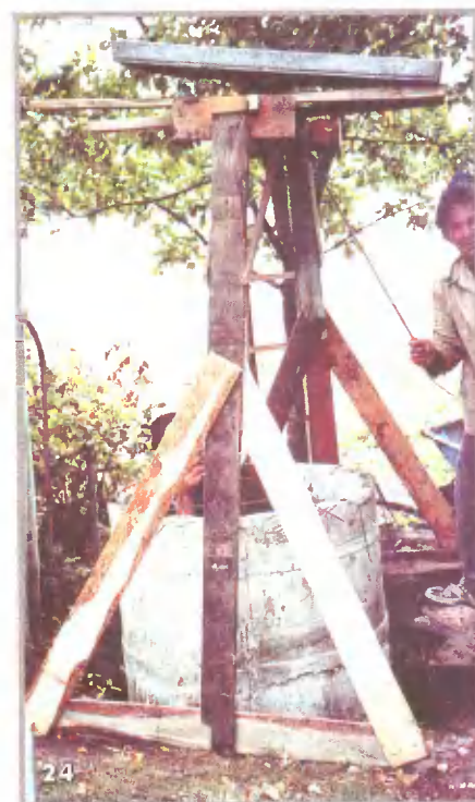
Во время установки секции она постоянно наклонялась, но благодаря зазору между грунтом и бетонной поверхностью ее ни разу не заклинило
