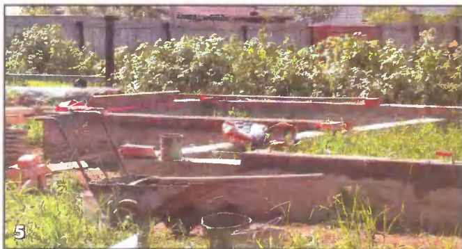
По весне фундамент пришлось выравнять кладкой кирпича
