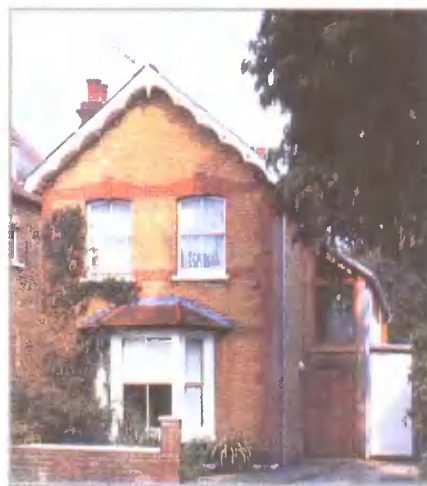
Обособняк был построен в середине XIX века в викторианском стиле
