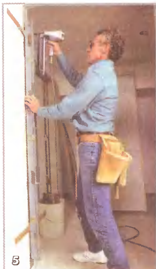
5 Крепление прокладок. Чтобы удержать прокладки по отметкам, прижмите их уровнем к стойкам
