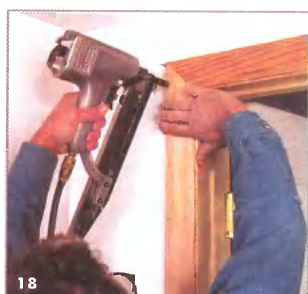
Крепление прокладок. После подгонки прибейте углы наличников к стене гвоздями. Все зазоры между стеной и наличниками зашпаклюйте
