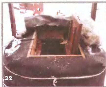
Чтобы вода в колодце не замерзала, оголовок утеплен слоем опилок
