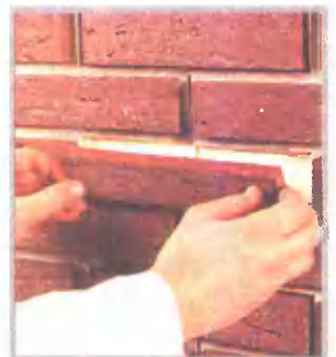
Приклеивание соединительных кирпичей
