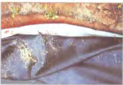
Чтобы пленка не порвалась, камни и корни растений удаляют, а котлован засыпают слоем песка толщиной 2...5 см (в зависимости от неровностей). Для более надежной защиты пленки под нее на подсыпку укладывают войлок
