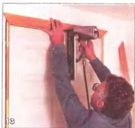
Установку наличников начните с верхней детали. Один гвоздь забивайте в коробку, другой — в верхнюю перемычку проема
