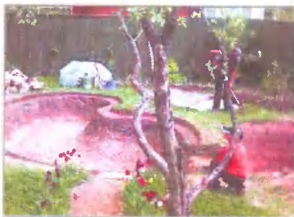
Котлован пруда в окончательном виде. Выбранный грунт можно вывезти, но гораздо лучше использовать его для реорганизации ландшафта вблизи водоема
