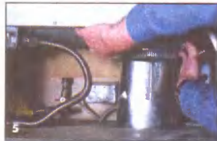
Установка плиты. Чтобы не поцарапать столешницу, регулируемые ножки плиты на время монтажа выставлены на большую, чем нужно, высоту
