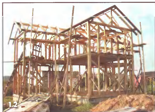
12 Каркас еще в лесах, но монтаж его завершен
