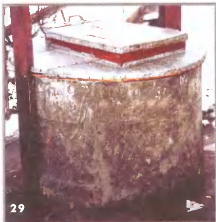
Колодец закрыт обшитым железом деревянным щитом с двухсекционным люком. Две отдельные крышки обеспечивают удобство пользования колодцем в различных режимах
