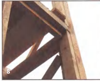
Крепление межэтажной обвязки каркаса к угловой стойке
