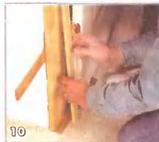
10 Укрепление косяка со стороны замка. Сначала снимают ограничители...
