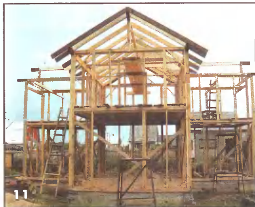
11 Стропила несут не только нагрузку на кровлю, но и всему каркасу придвоят прочность и жесткость
