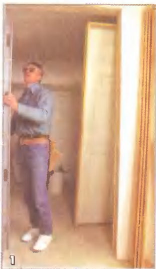
Проверка проема. Перед установкой двери убедитесь, что стойки вертикальны по обоим сторонам проема. Для этого можно использовать уровень длиной 1,8 м
