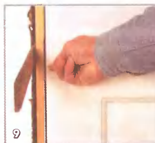
9 Регулировка положения коробки со стороны замка. С помощью прокладок добейтесь, чтобы зазор по всей высоте дверного полотна был равномерным
