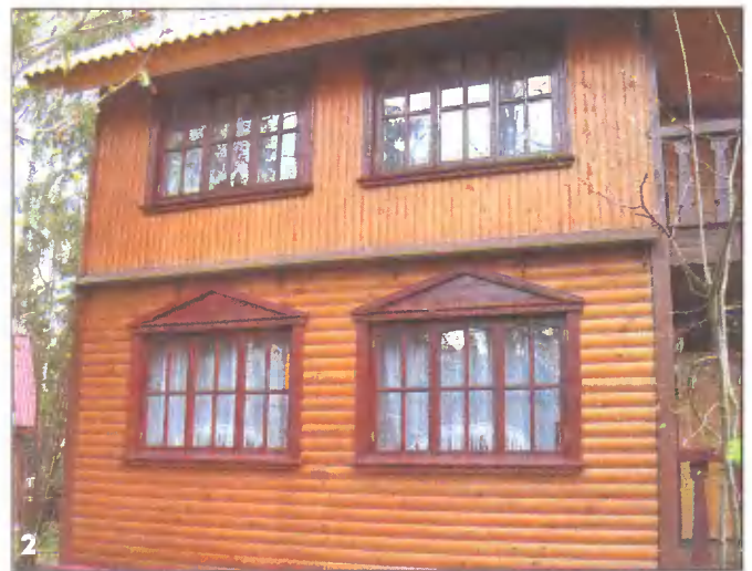
Блокхаус можно располагать на стенах горизонтально, вертикально и даже под углом
