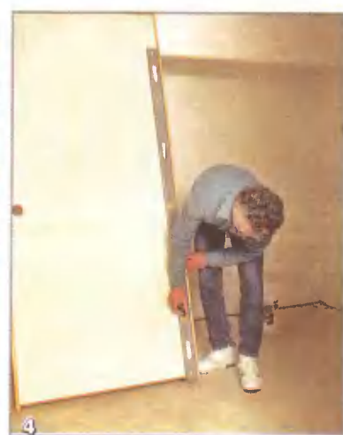
Разметка положения петель. Воспользовавшись длинным уровнем или измерительной рейкой, отметьте центры верхней и нижней петель
