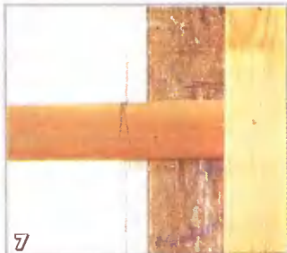
7 Регулировка положения коробки со стороны петель. Добившись вертикальности косяка, сделайте отметку его правильного положения на прокладках
